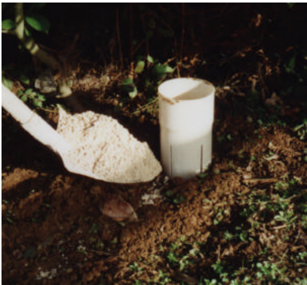
FOTO 3 - Posa in opera di ghiaietto calibrato 3-5 mm quale filtro tra il terreno ed il tubo
